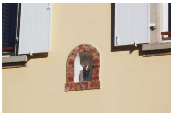
Niches protectrices rue du Général de Gaulle
