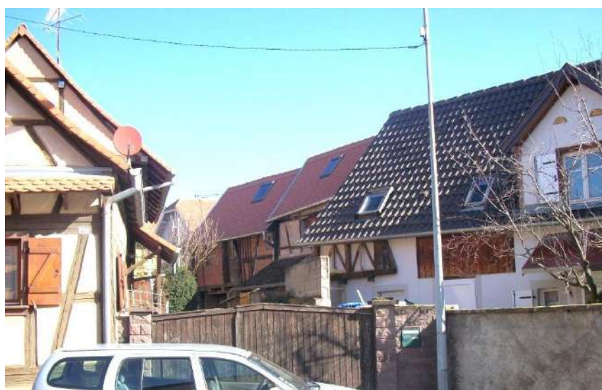
Exemple de réhabilitations de dépendances – Rue de la Libération
