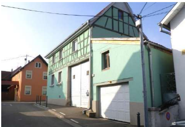
Exemple des aspects extérieurs du bâti ancien.
