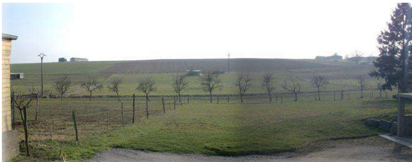
Constructions agricoles implantées sur la ligne de crête
