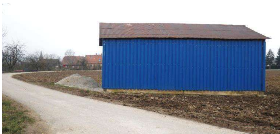
Bâtiment agricole bleu, très visible dans le paysage agricole
