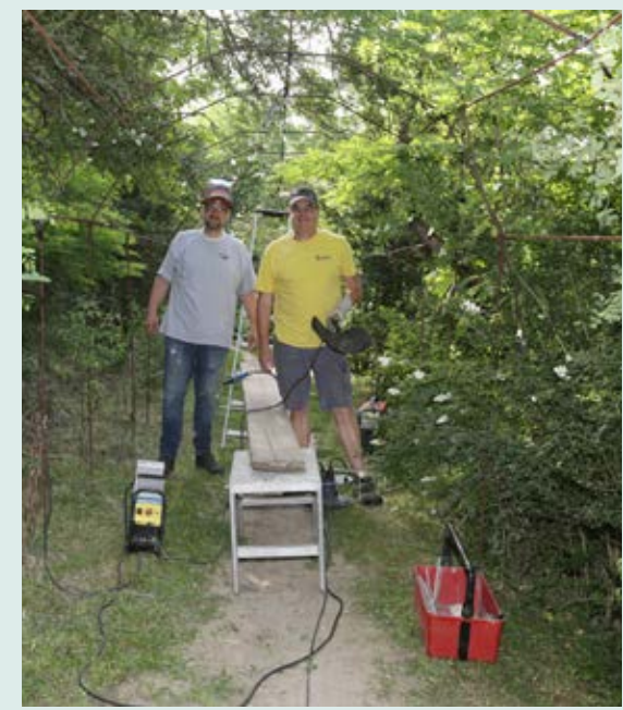
18 Finalisation de la soudure de l'arche au sentier botanique
