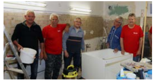
Installation d'une cuisine dans la salle des retraités
