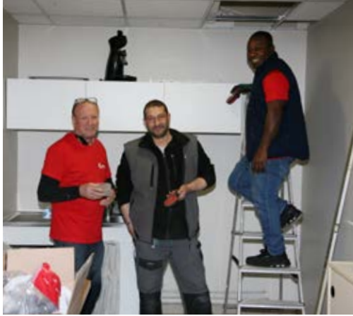
Mise en place d'un point d'eau à la bibliothèque
