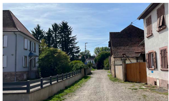
Réfection des rues de l'école et du ruisseau
